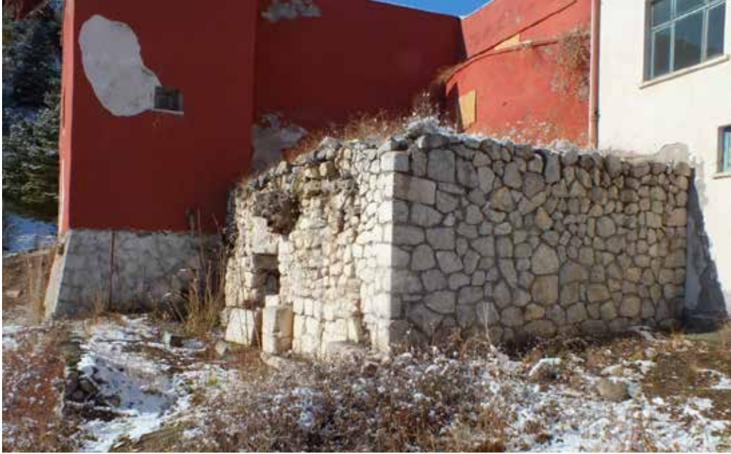
Şekil 4: Beke Kaplıcasının dıştan görünümü
