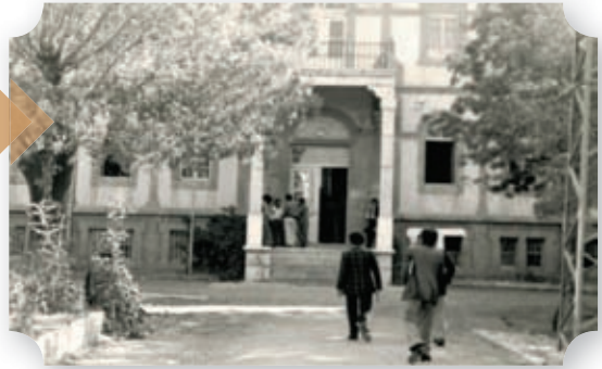
1976-1980 Yılları Arasında Çorum Makine MYO Olarak Hizmet Veren Taş Bina (Bugünkü Müze Binası)
