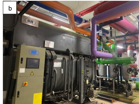
Şekil 2. (a) Gaz Motoru ve (b) Absorpsiyonlu Chiller
