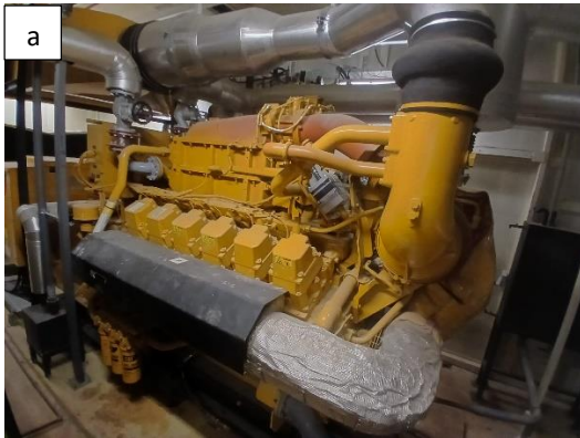
Şekil 2. (a) Gaz Motoru ve (b) Absorpsiyonlu Chiller
